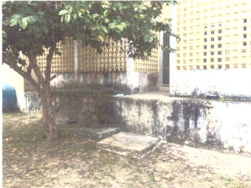
Local da ampliação
