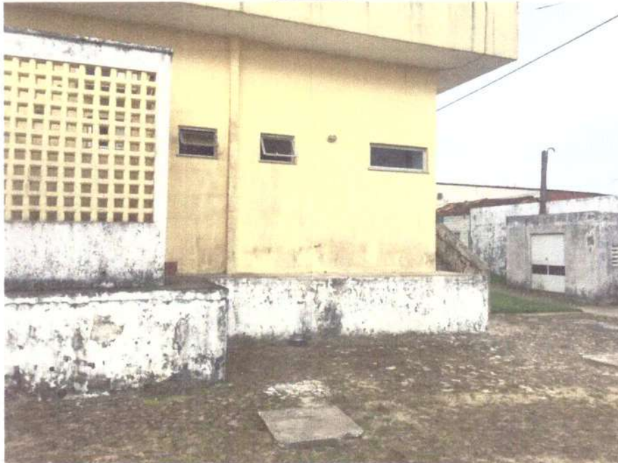
Detalhe do nível zero da nova edificação
