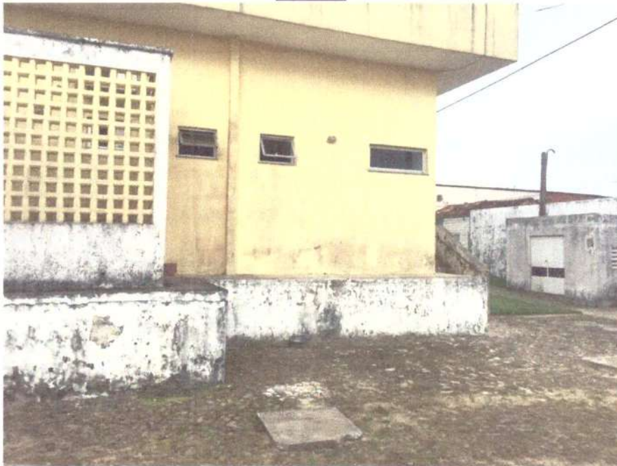
Detalhe do nível zero da nova edificação
